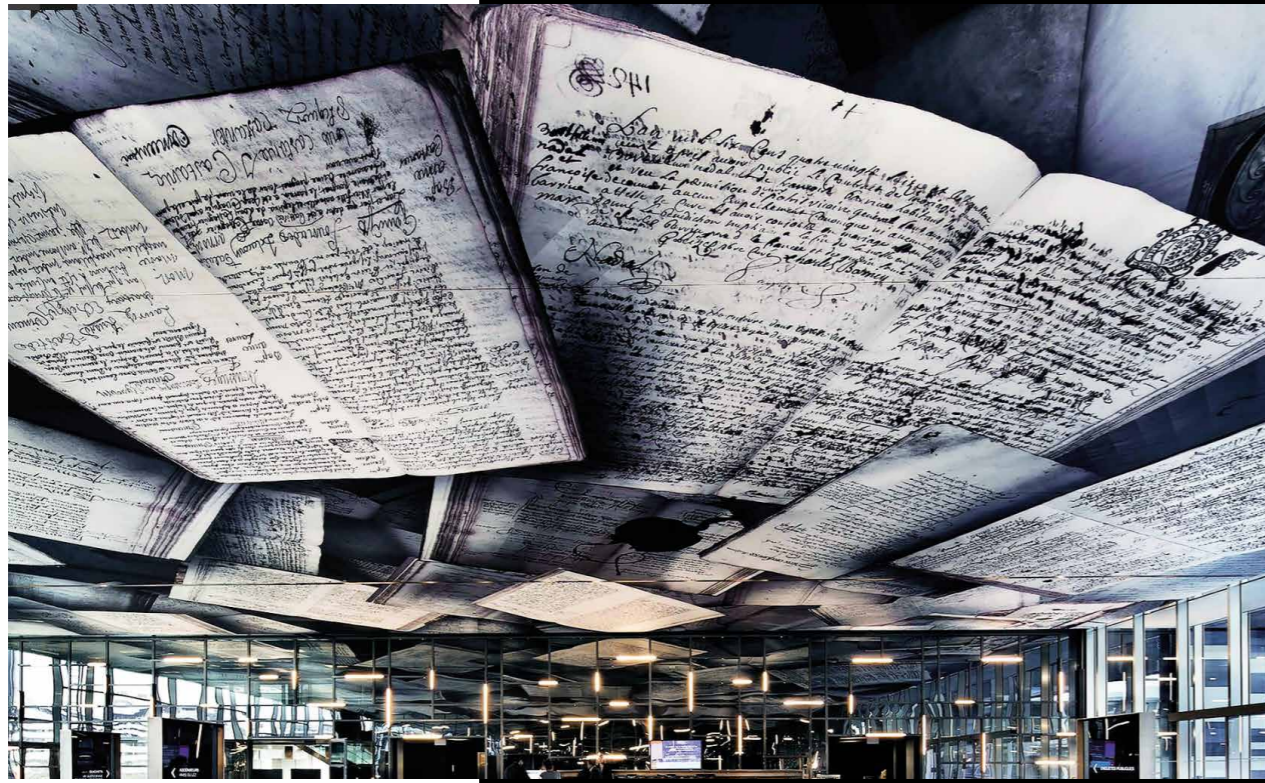
Hôtel de Ville de Montpellier – Architectes : Jean Nouvel, François Fontès. Solution utilisée : PONGS® - DESCOR® PREMIUM Acoustic avec impression numérique
